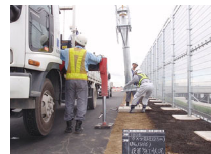
場周道路外側フェンス付近への監視装置の設置
