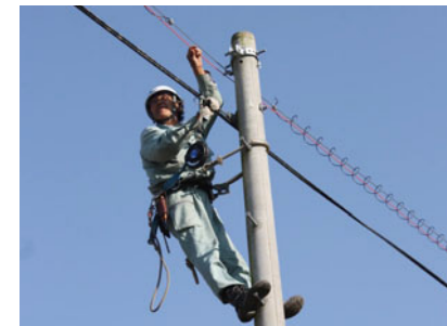
大島区の山間部に光ファイバを敷設。
