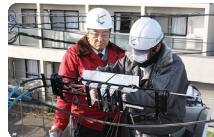
高島社長による施工現場視察（日本コムシス 杉並TS）
