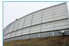
サーキット場の防音フェンスの裏に(露出配管を固定し)光ケーブルを敷設
