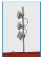
コントロールタワーの屋上には無線アンテナの親機を設置
