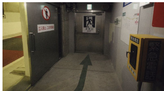
本線に沿って設置されている独立避難通路にも、火災などの緊急時に安全に地上へと誘導するための拡声放送スピーカーや非常電話を設置。そのための通信ケーブルの敷設など狭所での作業も担当しています
