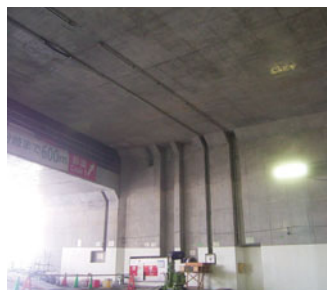
高い天井にも通信ケーブルを敷設
