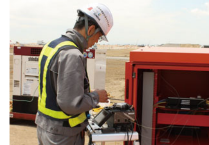
各種誘導装置と空港庁舎とをつなぐ通信ケーブルの敷設
