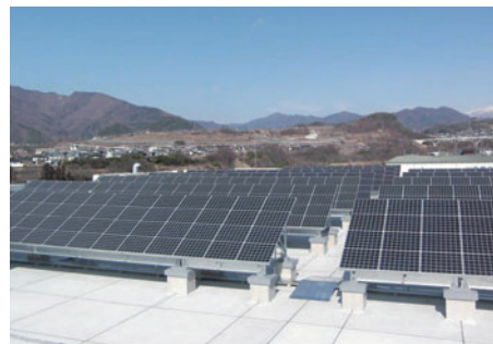
東日本システム建設施工例
