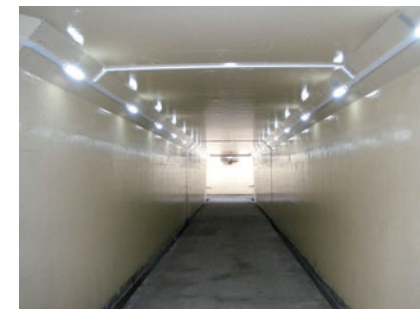
東日本システム建設 施工例
