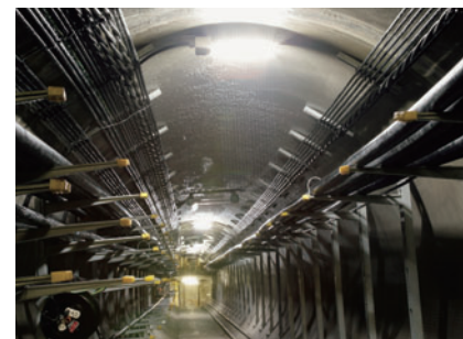
日本コムシス施工例
