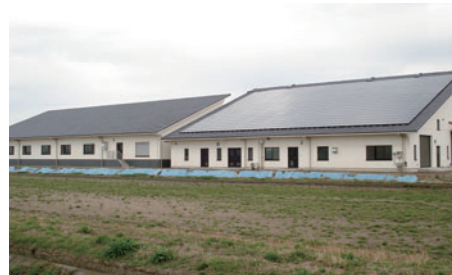
屋根を覆う太陽電池モジュール
