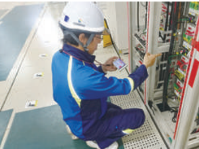
Darwin Mobileを使用している現場の様子
