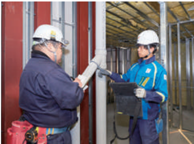
千里眼を使用している現場の様子
