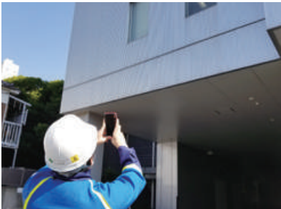
SunMOSによる現場状況の確認
