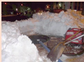
マンホールの除雪および排水作業
