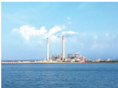
タンジュン・ジャチB石炭火力発電所
