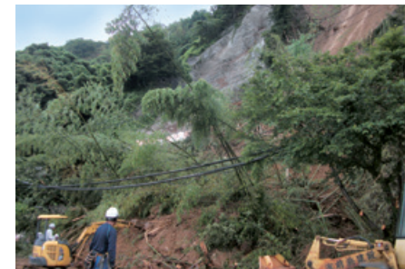
佐渡豪雨災害の復旧作業では 豊かな自然環境にも配慮
