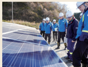
太陽光パネル設置現場を見学
