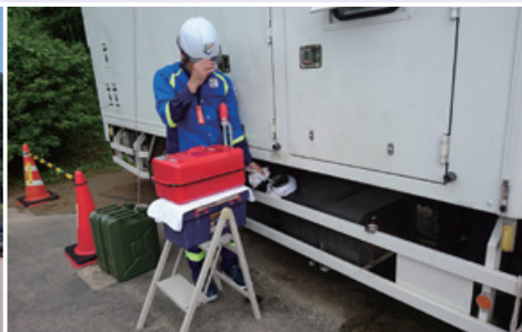
復旧作業の様子
