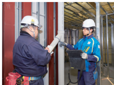
千里眼を使用している現場の様子
