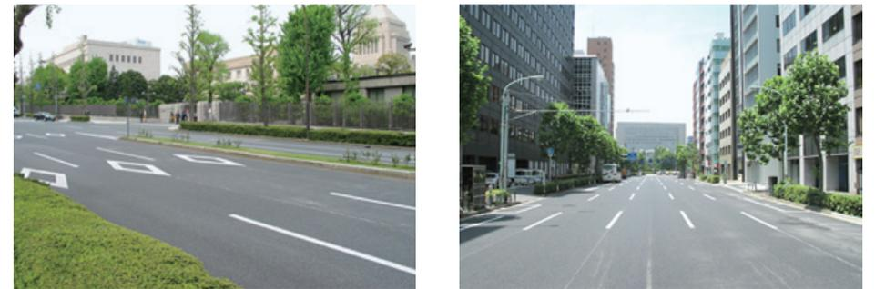
東京舗装工業が手掛けたヒートアイランド抑制効果がある保水性舗装
