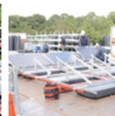
3 パネルを設置
