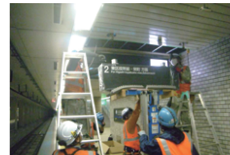
東豊線案内表示設備工事の様子
