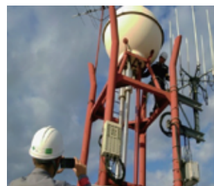
SunMOSにより現場状況を撮影
