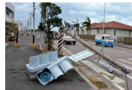
台風により倒れた電柱
