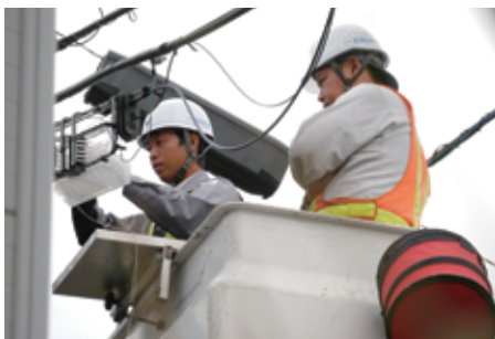
インストラクターに教わりながら 光接続工事を行う2年目社員
