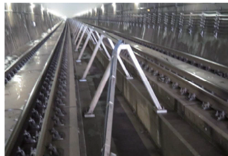
青函トンネルでの接続工事
