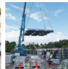
4 クレーンで吊り上げ
