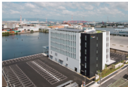
コムシス平林ビル外観
