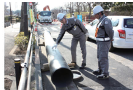
現場視察の様子
