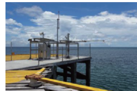
潮位計の設置
