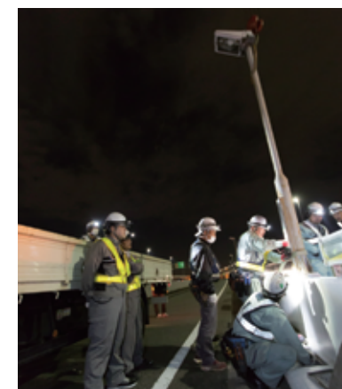
古くなったボール照明を取り外す様子
