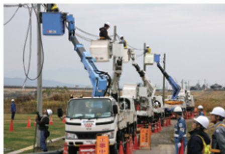
4スパンに及ぶケーブルの張り替え作業
