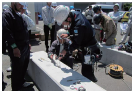
アンカー打ち施工訓練
