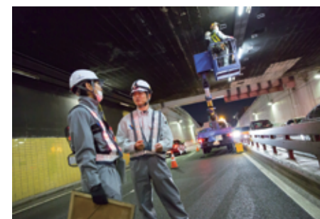
夜間帯に実施するLED化改修工事
