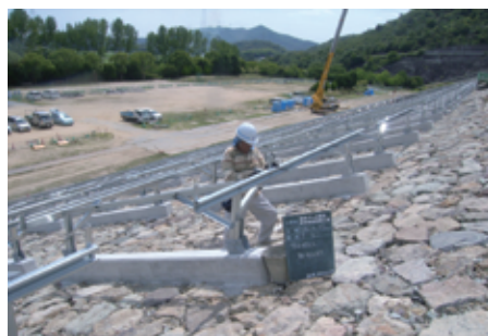
安全を考慮し、下から順に設置
