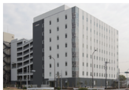
コムシス品川港南ビル外観
