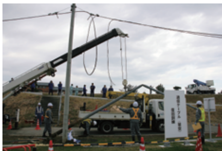
折損した電柱の建て替え作業
