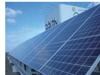
また、TOSYSでは本社ビル屋上に最大出力50kW、つうけんでは厚別ビルに最大出力10kWの太陽光発電システムをそれぞれ導入しています。2012年度はコムシスグループで約39.6t-CO<sub>2</sub>の二酸化炭素削減効果を実現しました。
