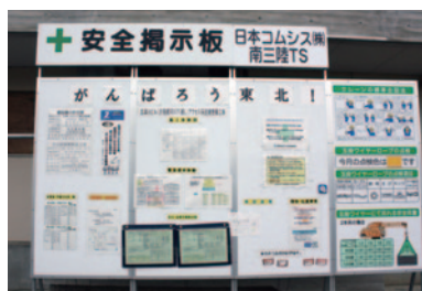
工事現場にある安全掲示板
