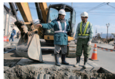
土木工事の現場にて指示をする亀山
