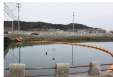
川の下流側にオイルフェンスを張り、汚水が海に流れ込まない為の対策
