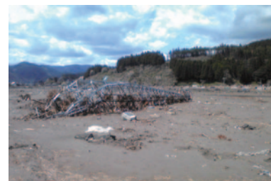
震災被害により壊れた基地局
