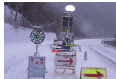
事故予防の工事看板
