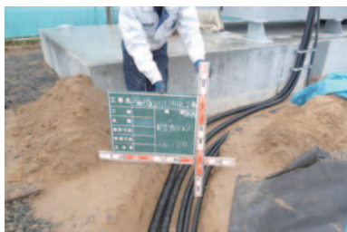
電源線の配管工事
