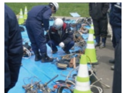
機器工具一斉点検 昇降用転落防止器具点検、 張線器の点検など
