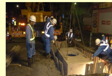
CCBOX (電線共同溝)の構築工事
