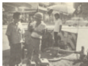
バンコク線路工事(1965.12)
