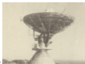
衛星通信工事(1970.9)
