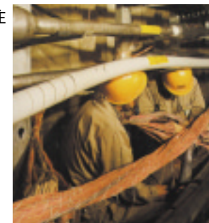
ケーブル切換工事(1978年当時)
