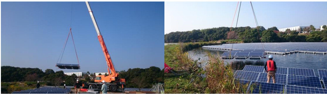
ユニットとして組み立てたパネルをクレーンで吊り上げ水上に浮かべる様子
